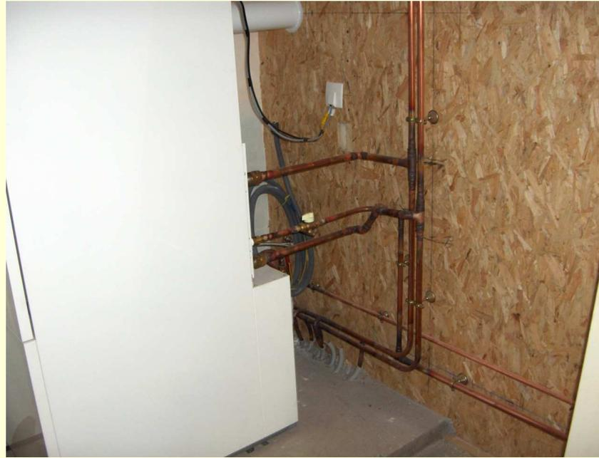
**Etape 36 : Installation de la chaudière thermique avec arrivées d'eau et d'électricité**
