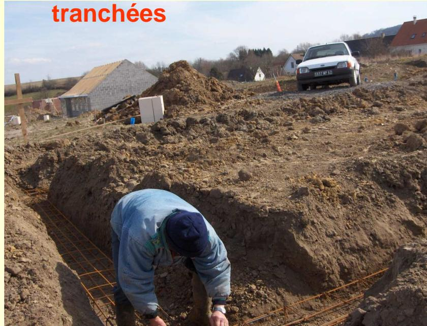
**Etape 2 : Le maçon prépare le ferrailage pour la semelle de fondation.**
