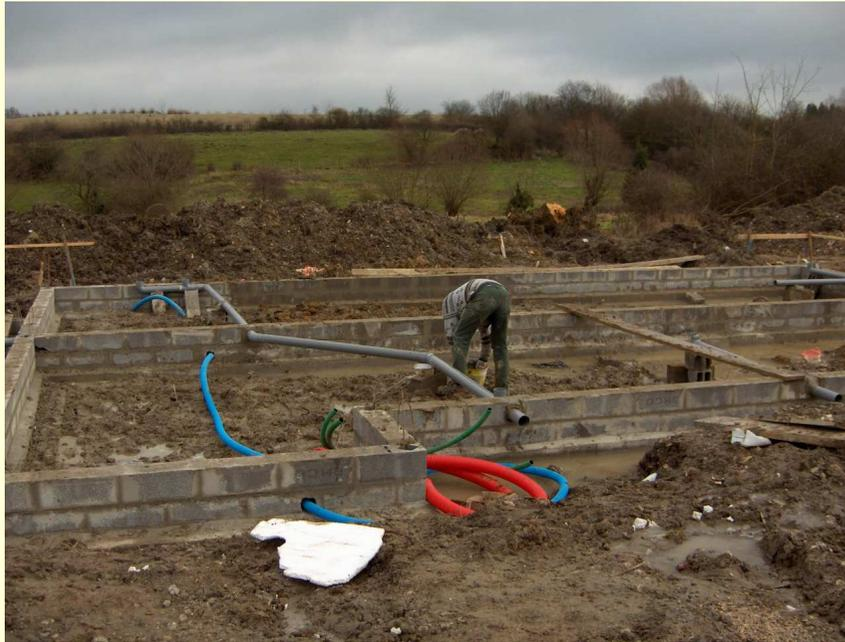
**Etape 5 : Les murs de soubassement sont achevés. Le maçon pose les tuyaux d'évacuation des eaux usées.**
