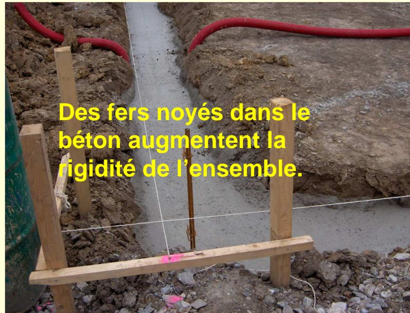
**Des fers noyés dans le béton augmentent la rigidité de l'ensemble.**
